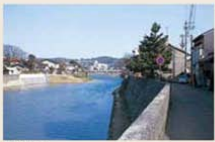
堀川揚場周辺
